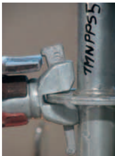
Figura 4.2.1.8-5: Imbozzamento del montante (evento b)
