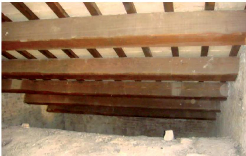
*Copertura della sala sorretta da una travatura realizzata con struttura in legno appoggiata direttamente alla muratura perimetrale dell'edificio*
