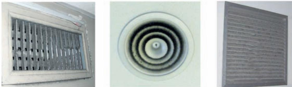
**Figura 2** – Condizioni di alcune griglie/bocchette di impianti di ricambio e trattamento dell'aria.
