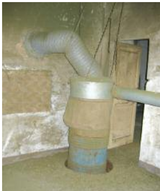
Figura 2 - Esempio di possibile sorgente di emissione di grado continuo (interno sistema di trasporto), primo (connessioni) e secondo (manicotti)
