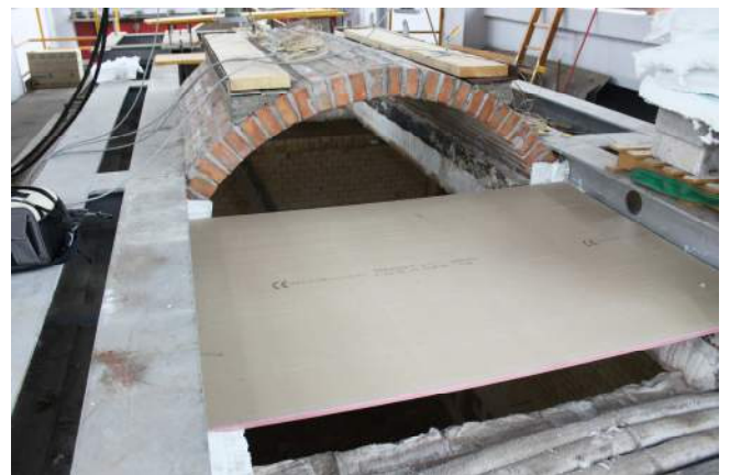
15/6/2015 – figura 53 Inizio tamponatura del forno
