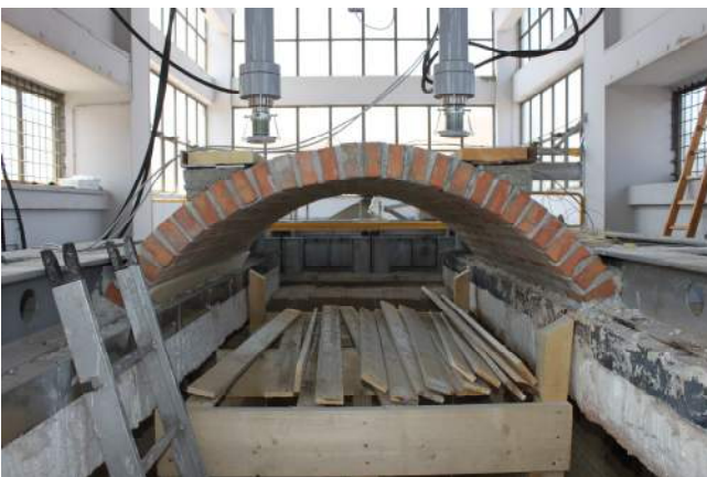
10/6/2015 – figura 52 Vista frontale della volta
