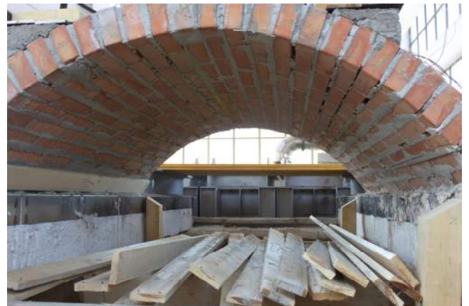
10/6/2015 – figura 51 Vista all'intradosso della volta prima della stilatura dei giunti
