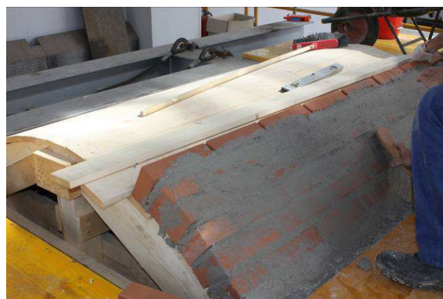
14/5/2015 – figura 29 Prosecuzione della realizzazione della volta muraria
