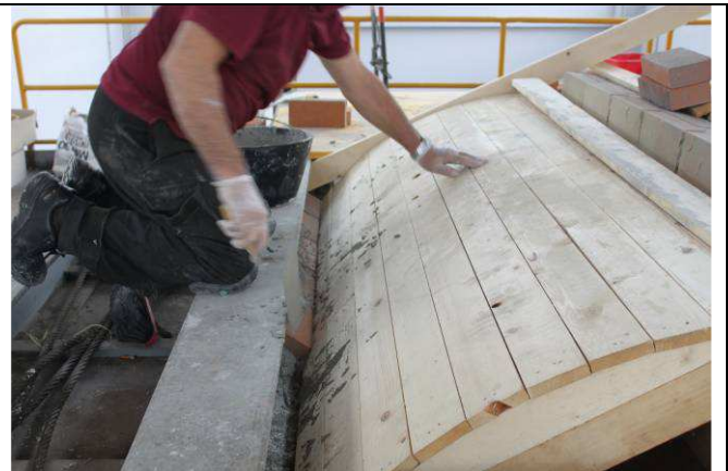
15/5/2015 – figura 31 Inizio della realizzazione della seconda metà volta muraria a partire dalla sezione di imposta alle reni
