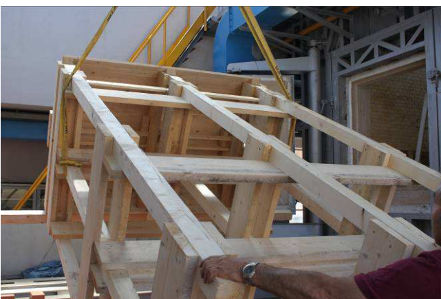
12/5/2015 – figura 22 Issaggio della centina
