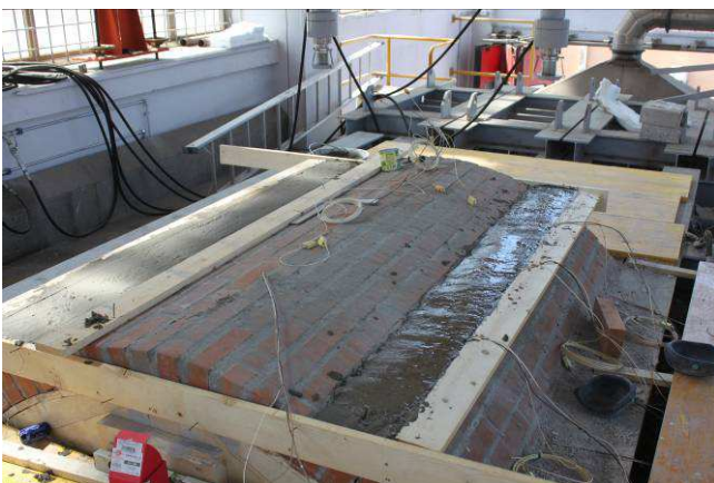
19/5/2015 – figura 40 Getto dei cordoli di ripartizione del carico (vista degli spinotti di ancoraggio Ø8)
