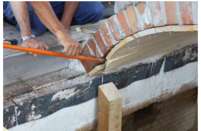
10/6/2015 – figura 49 Rimozione del tavolato
