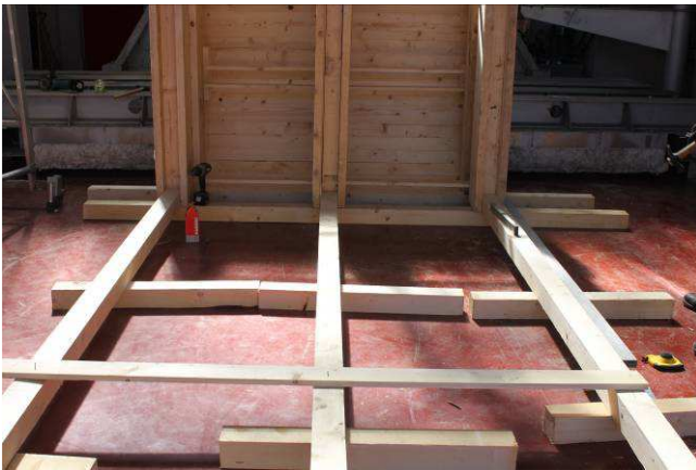
11/5/2015 – figura 18 Inizio realizzazione piedritti centina
