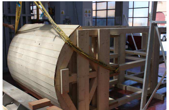
11/5/2015 – figura 21 Imbragatura della centina e collegamento al carroponte
