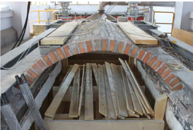
10/6/2015 – figura 50 Completamento della scasseratura e vista dall'alto della volta
