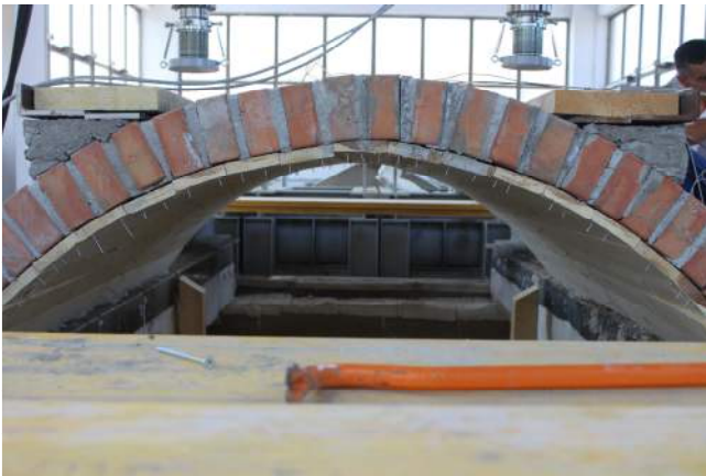
10/6/2015 – figura 48 Rimozione della centina
