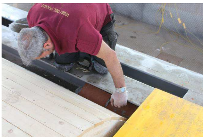
13/5/2015 – figura 28 Inizio della realizzazione della prima metà volta muraria a partire dalla sezione di imposta alle reni
