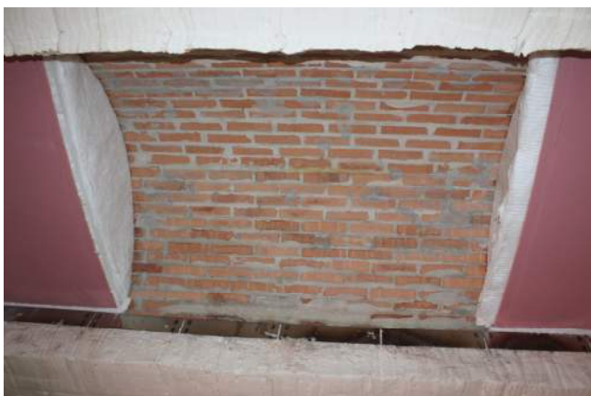
23/6/2015 – figura 58 Completamento della tamponatura del forno orizzontale
