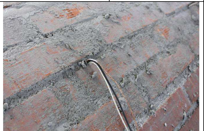
18/5/2015 – figura 35 Particolare dei cavi compensati delle termocoppie interne in corrispondenza della sezione di applicazione del carico (n. 3 per sezione di misura)
