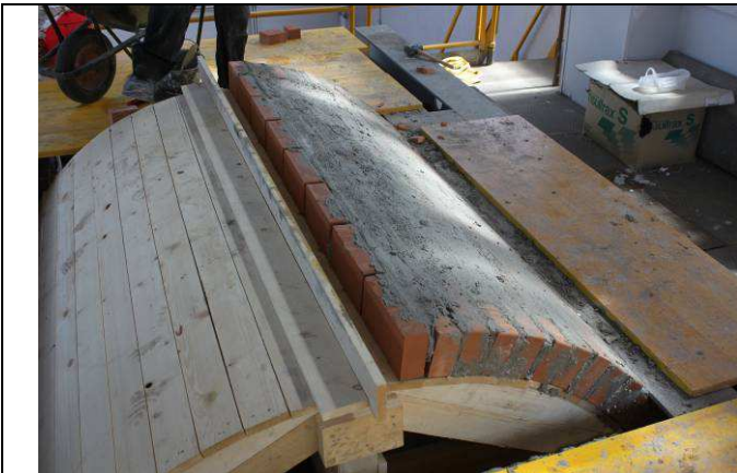
14/5/2015 – figura 30 Completamento della prima metà della volta muraria
