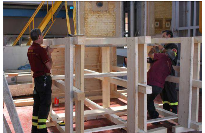
11/5/2015 – figura 19 Fasi di realizzazione piedritti centina
