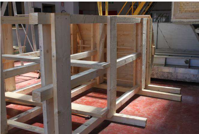
11/5/2015 – figura 20 Completamento realizzazione piedritti centina
