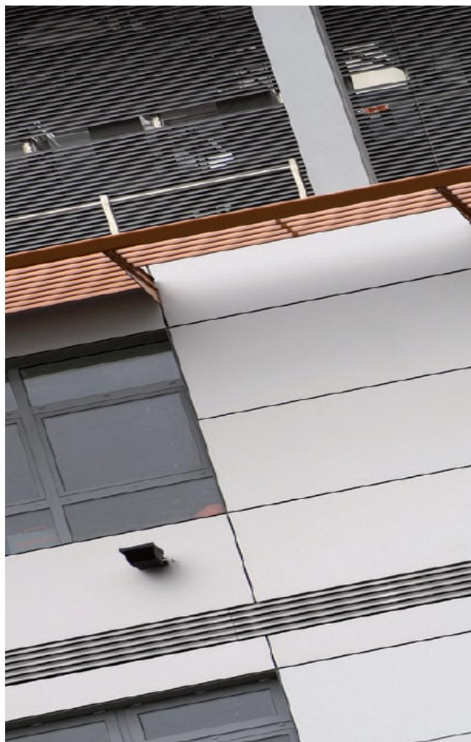
Grazie alla presenza di tali cavità esterne il fuoco, oltre che in direzione verticale, può estendersi anche in direzione orizzontale, fino a raggiungere aree o compartimenti della costruzione giudicati addirittura inaccessibili (sottotetti, soffitte, depositi...), a causa della rottura o del cedimento dei rivestimenti esterni.
