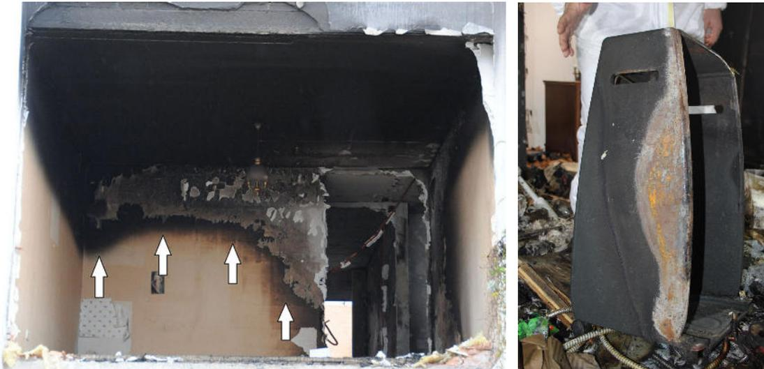
La foto in alto a sinistra mostra un'evidente "linea di demarcazione", provocata sul muro dal fumo e dal calore che si sono sprigionati durante l'incendio. La foto in alto a destra mostra sempre una linea di demarcazione, lasciata dal calore sulla superficie metallica di una stufetta.
