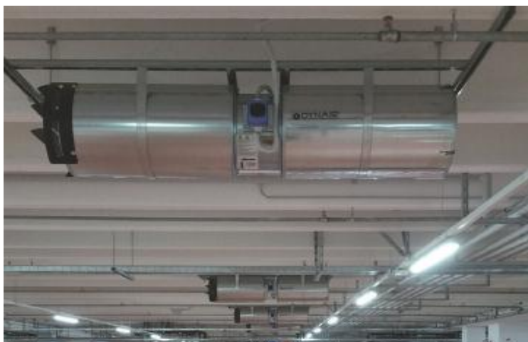
Disposizione JET FAN Dynair Zona 1
