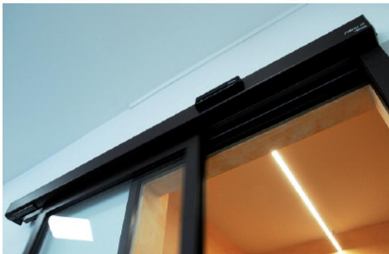
Equipaggiata con elettroblocchi che le impediscono l'apertura anche in assenza di alimentazione elettrica e con elettronica dedicata.
