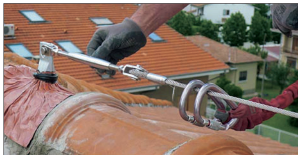
Figura 1 - Incorporazione tra ancoraggio e struttura di supporto.
