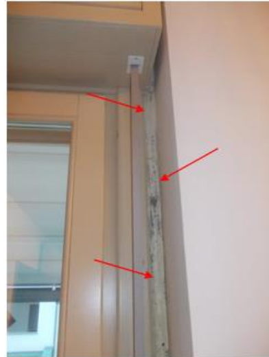
Figura 2: Ripresa fotografica fenomeni di formazione di muffe evidenti in corrispondenza del nodo parete- serramento
