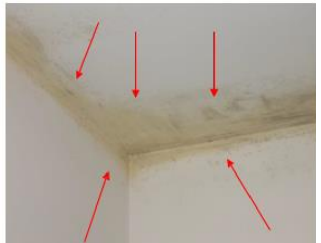
Figura 1: Ripresa fotografica fenomeni di formazione di muffe evidenti in corrispondenza del nodo parete verticale- solaio
