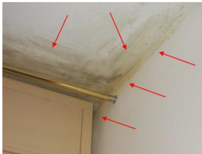
Figura 3: Ripresa fotografica fenomeni di formazione di muffe evidenti in corrispondenza del nodo parete verticale- solaio piano sesto
