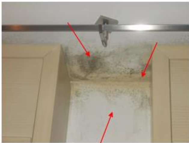
Figura 1: Ripresa fotografica fenomeni di formazione di muffe evidenti in corrispondenza del nodo parete verticale- solaio
