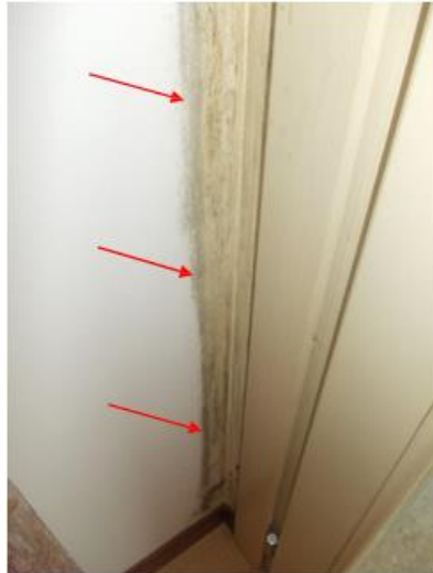
Figura 2: Ripresa fotografica fenomeni di formazione di muffe evidenti in corrispondenza del nodo parete- serramento
