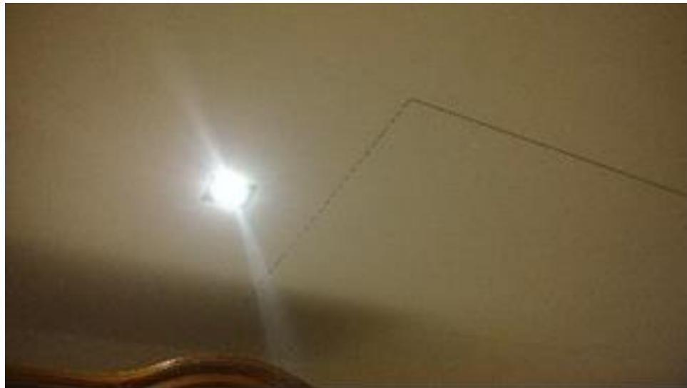
Figura 19: Installazione impianto VMC - Controsoffitto con botole ispezione macchina
