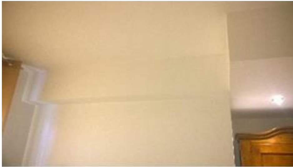
Figura 18: Installazione impianto VMC - Controsoffitto canalizzazioni
