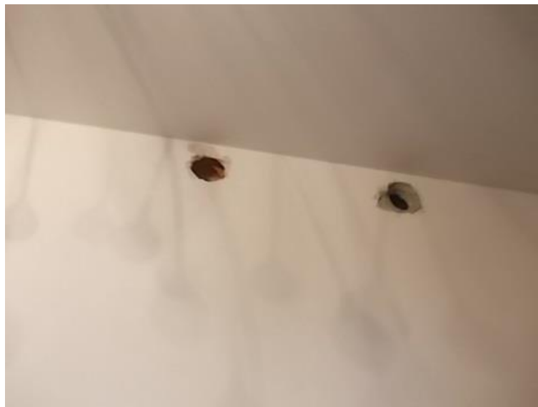
Figura 12: Installazione impianto VMC - Forometrie passaggio canalizzazioni
