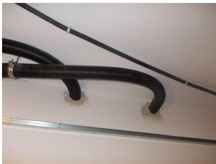
Figura 13: Installazione impianto VMC - Canalizzazioni
