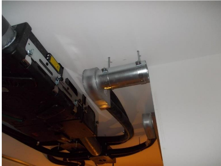
Figura 16: Installazione impianto VMC - Installazione macchina a soffitto
