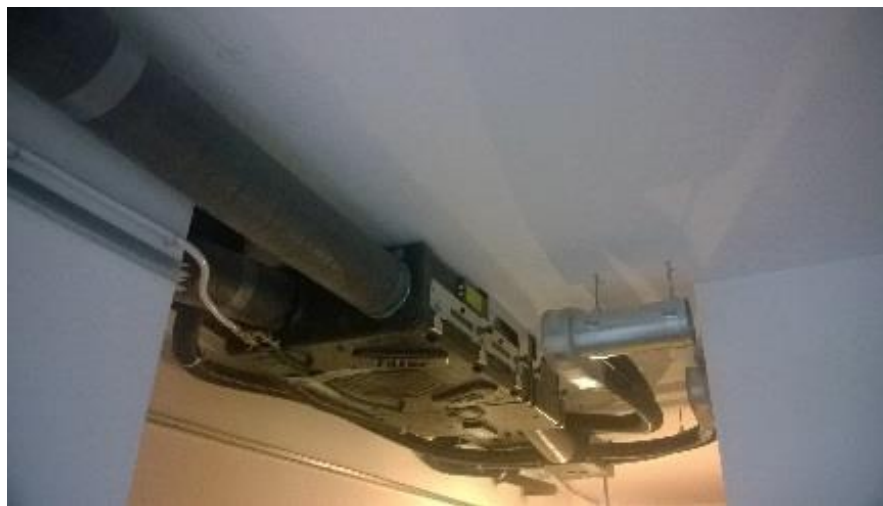
Figura 15: Installazione impianto VMC - Installazione macchina a soffitto
