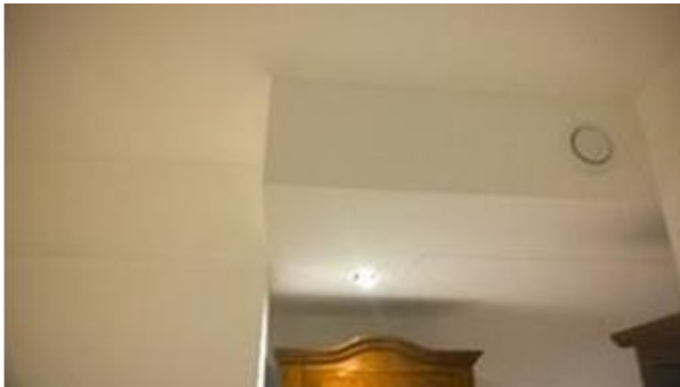
Figura 17: Installazione impianto VMC - Controsoffitto con botole ispezione
