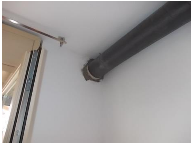
Figura 14: Installazione impianto VMC - Canalizzazioni
