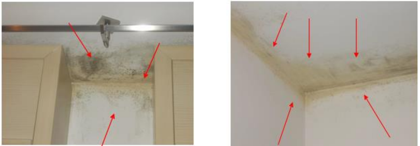
Figura 1: Ripresa fotografica fenomeni di formazione di muffe evidenti in corrispondenza del nodo parete verticale- solaio
