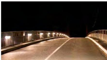
Figura 3 - Le riflessioni di Brewster con condizioni meteo avverse sono eliminate con l'illuminazione laterale ed apparecchi bassi
