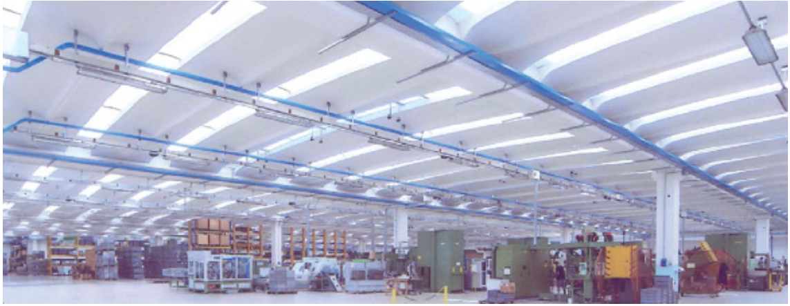
Figura 4 - Vista interna di copertura in tegoli alari
