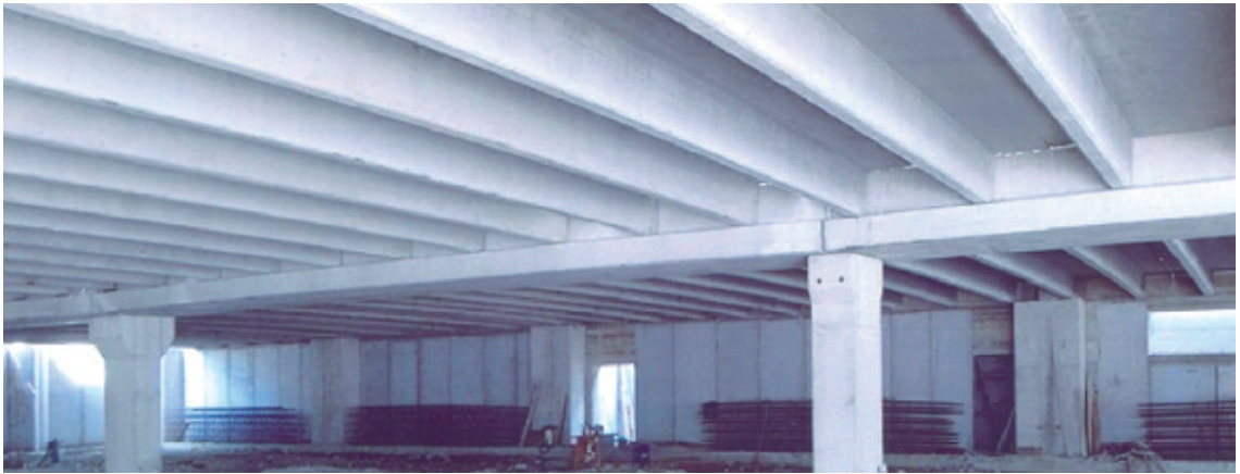
Figura 2 - Vista all'intradosso di impalcato in tegoli TT
