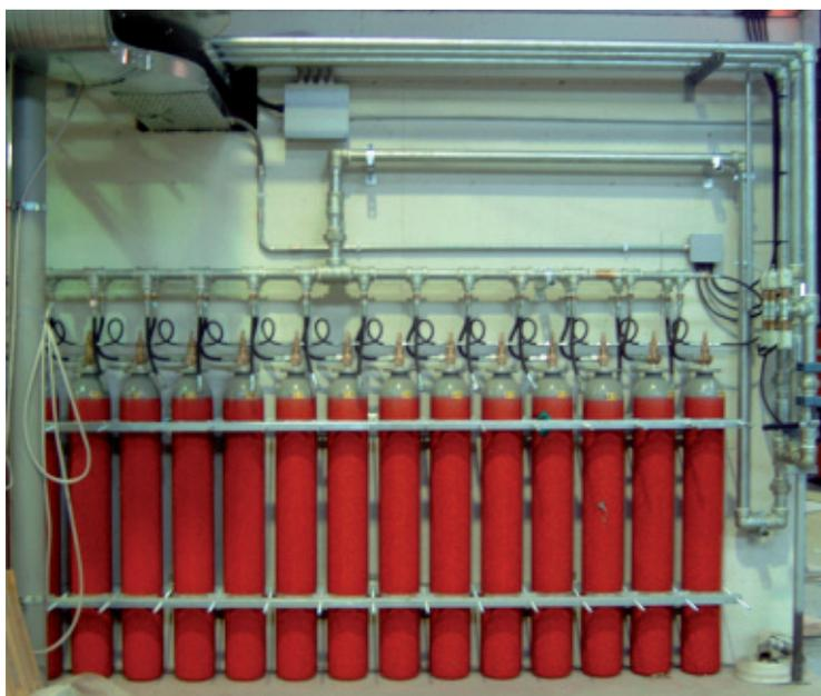
Impianto di spegnimento CO<sub>2</sub> a protezione macchina trafilatura alluminio - Anno 2012
