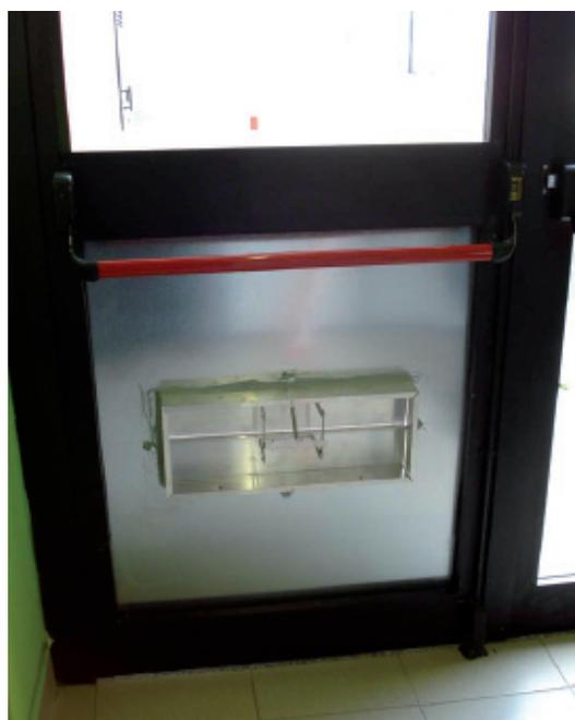
*Foto 14 - Una serranda di sovrappressione nel telaio di una porta di ingresso*
