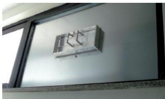
*Foto 15 - Una serranda di sovrappressione all'interno di un finestrone (vista interna)*
