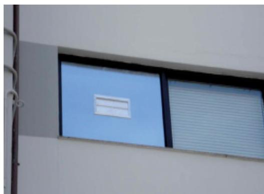
*Foto 13 - Una serranda di sovrappressione all'interno di un finestrone (vista esterna)*
