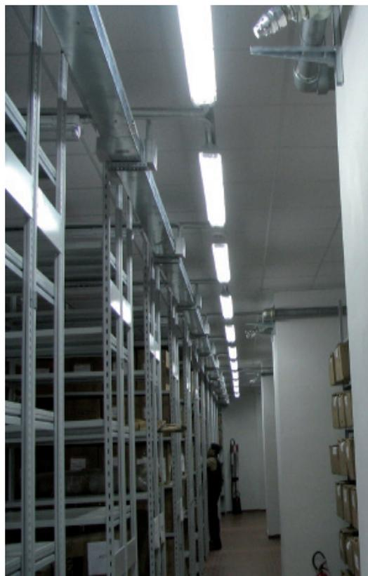
Foto 1 e 2 - Particolari delle scaffalature metalliche. Sulla parete opposta si notano gli ugelli dell'impianto di spegnimento
