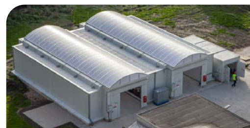
Il centro di stoccaggio realizzato da Denios Se per Holcim
