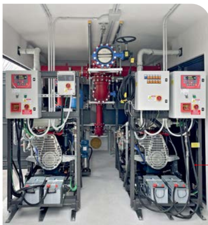
Veduta interna di un vano tecnico antincendio Fourgroup (fornibile con gruppo antincendio installato sottobattente, soprabattente o con "vertical turbine pumps")
