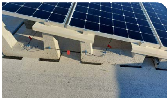
Nelle immagini: fissaggio del cavo sensore
