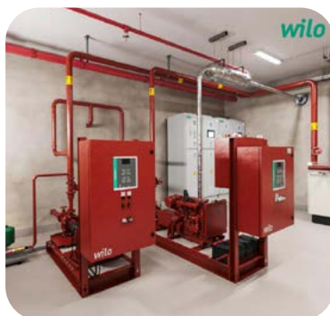
Gruppi di pompaggio Wilo-FireSet D e Wilo-FireSet E integrati nell'impianto antincendio, garantiscono affidabilità e sicurezza in caso di emergenza
