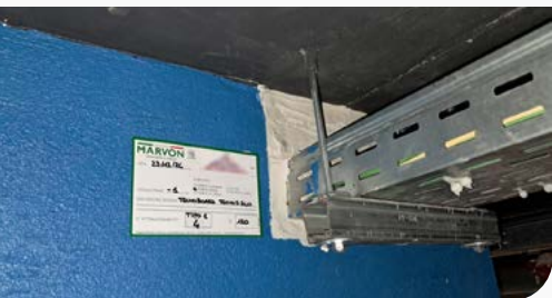
Attraversamento elettrico gestito con pannello Tecnoboard e sigillante Tecno S 240
