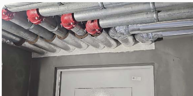
Attraversamento di tubazioni incombustibili gestite con coppella TecnoPIPE W, pannello Tecnoboard e sigillante Tecno S 240
