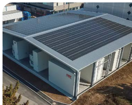
Il centro di stoccaggio ripreso da un drone
