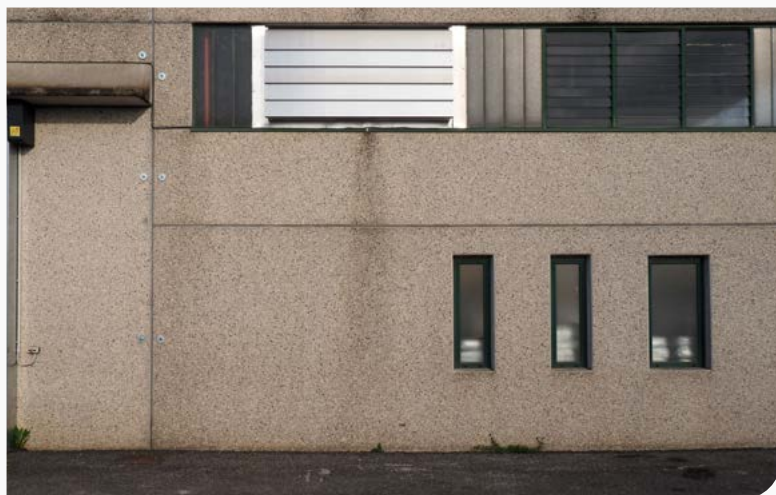
Veduta esterna della parete laterale con l'ENFC integrato nella fascia finestrata. Questa installazione dimostra come sia possibile realizzare un sistema efficiente anche in edifici esistenti, adattando i dispositivi alle condizioni architettoniche preesistenti senza interventi invasivi in copertura
