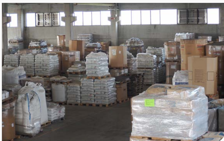
Vista d'insieme dell'interno magazzino con materiali stoccati e due evacuatori installati sul lato corto. La configurazione prevede la distribuzione degli ENFC su tutti i fronti per garantire uniformità di smaltimento. Nella parete visibile si osservano due evacuatori a lamelle su cinque totali, a servizio di un compartimento con scaffalature e merci infiammabili
