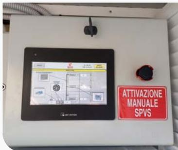
In alto: esempio di pannello di controllo con attivazione SPVS per le squadre VVF. A destra: gruppo Ventilante con motori EC
