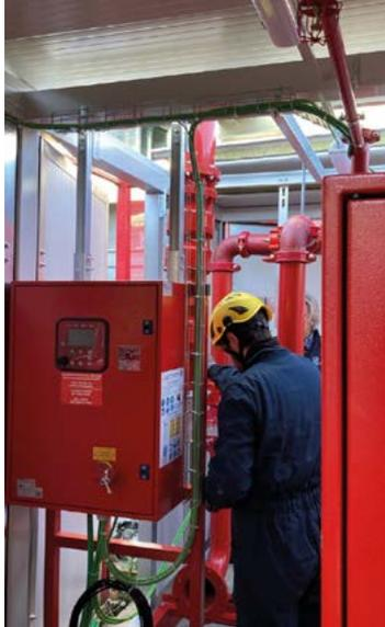
mità alla NFPA20, ovvero pump-set utilizzabili autonomamente o integrati in locali antincendio completi ed autonomi (FIREBOX), garantendo così un'ampia versatilità e possibilità di adattamento alle specifiche richieste, con un occhio di riguardo alla sicurezza per lo svolgimento delle manutenzioni periodiche.
