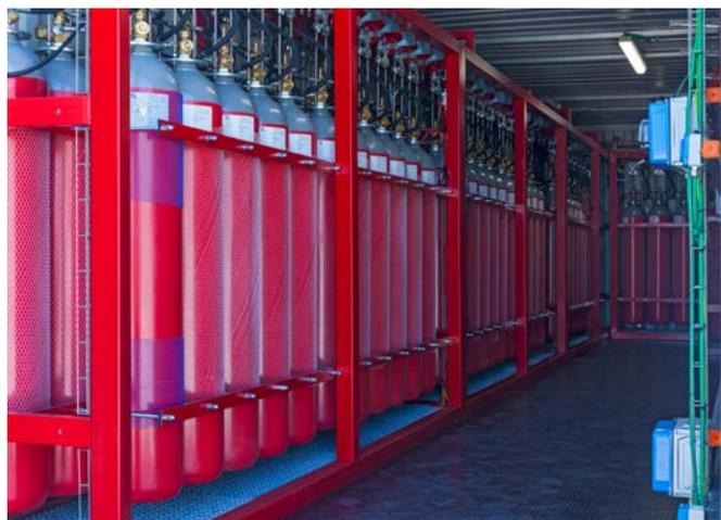
Impianto CO<sub>2</sub> realizzato per la protezione di una turbina da 500 MW
