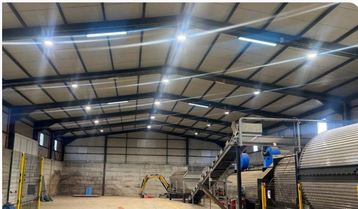
Struttura: vista d'insieme pre- intervento
