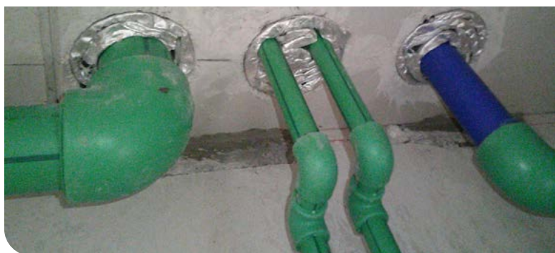
Attraversamento a soletta tubi multistrato e combustibili
