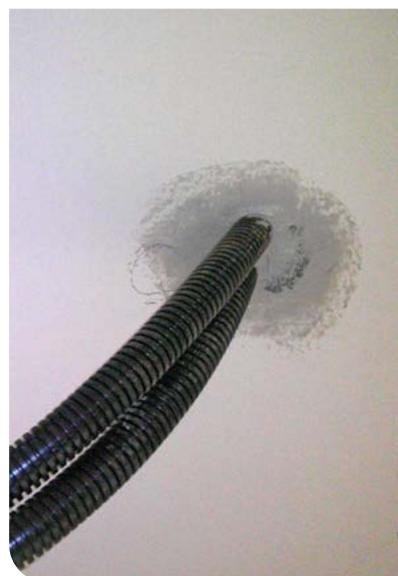
Con la nuova Norma CEI 64-8 è sempre necessario intervenire su passaggi di fascio cavi/ cavo o di fascio tubi corrugati/ tubo corrugato, anche quando l'elemento in attraversamento presenta un foro di passaggio di diametro inferiore a 32 mm, applicando un sistema certificato resistente al fuoco costituito da prodotti equivalenti a una guarnizione termo espandente a base grafica KM-FF108, sigillata con stucco
