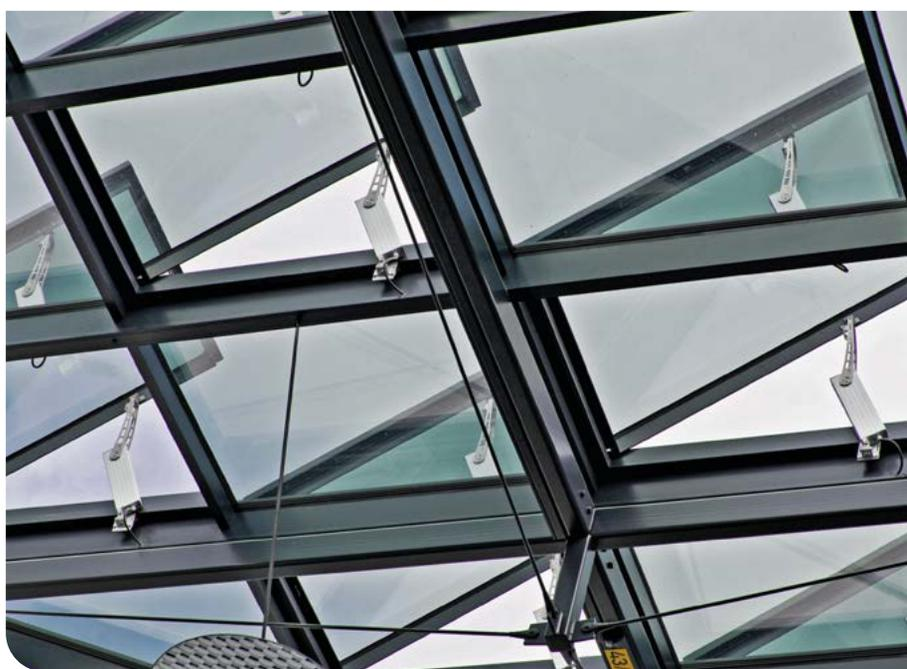
(conforme alla prova di resistenza al calore e al fuoco così come indicato dalla normativa EN 12101-2:2003), è specificamente progettato per l'apertura d'emergenza dei serramenti, mentre il quadro di comando gestisce l'attivazione automatica del sistema, monitorando costantemente lo stato dei componenti.
