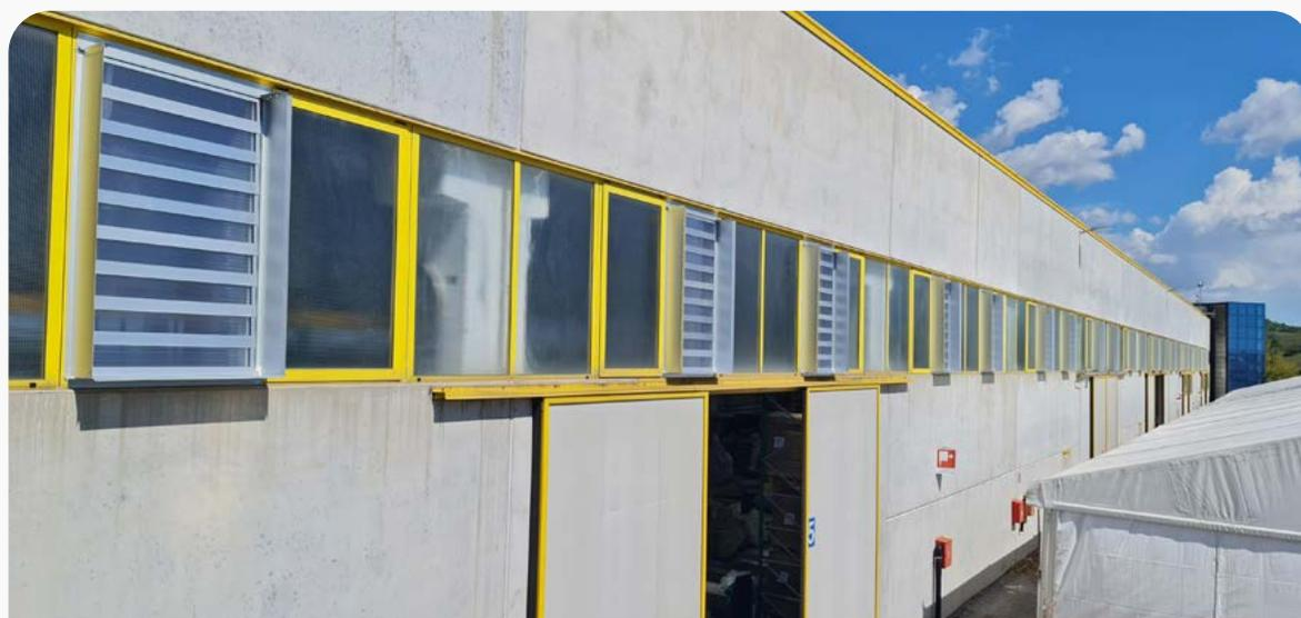
caratterizzato da una struttura prefabbricata a travi e pilastri in cemento armato e tamponamenti laterali sempre prefabbricati. La presenza in copertura di un parcheggio e quindi l'impossibilità di poter installare degli evacuatori a soffitto ha fatto ricadere la scelta su dispositivi come gli Smoke Lame che potessero essere installati a parete sfruttando le finestrate a nastro che si sviluppano lungo il perimetro dell'edificio.
