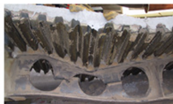
Prova sperimentale in scala reale: fase di rottura
