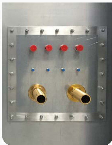
Figura 2 | Tipico attraversamento con impiego di guide d'onda in ottone
