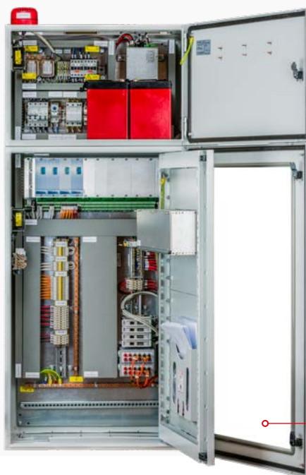
Cestello remoto collegato in fibra ottica
