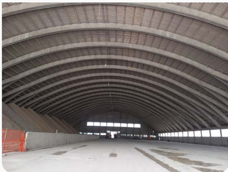
Figura 1 | Immagine dei locali prima dell'intervento
