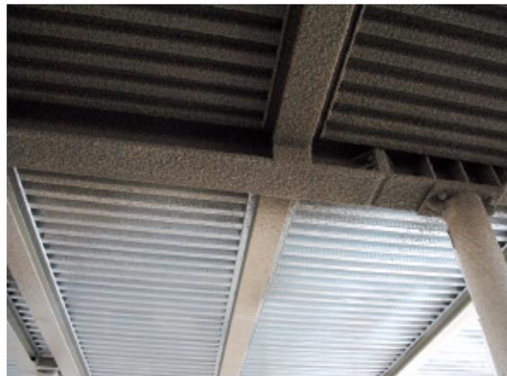
Protherm Light è un intonaco premiscelato leggero termoisolante per la protezione al fuoco (REI) delle strutture, certificato secondo D.M. 16/2/2007 con le normative europee EN 13381-3, EN13381-4, EN13381-5 con
